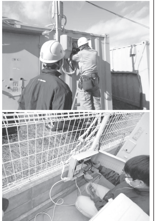
ブレーカー取替工事(上)と電圧測定を体験する生徒
