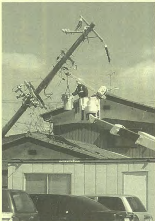
倒壊柱の撤去(いわき市)
