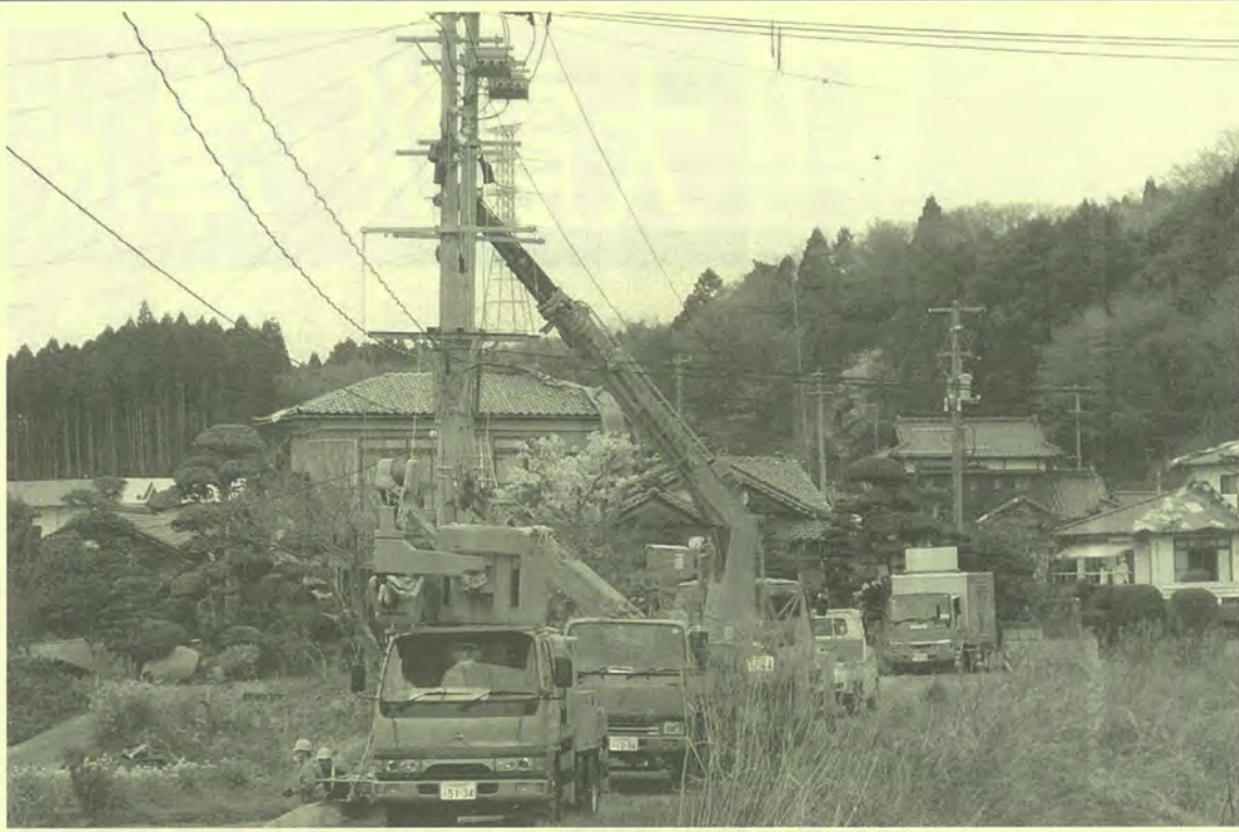
ブースタ柱の電柱傾斜の修復(いわき市)
