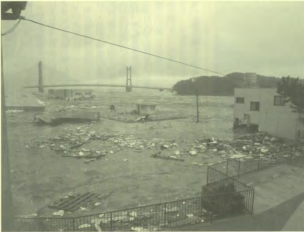
津波に襲われた松川浦漁港(松川浦大橋付近)
