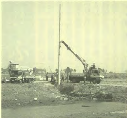
電柱の建て直し作業(南相馬市鹿島区)
