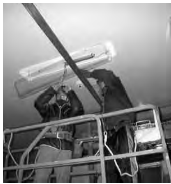
照明機器取付けの現場実習
