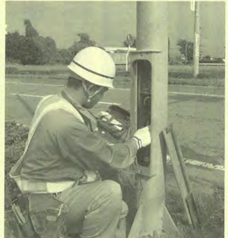
郡山支部の街路灯点検作業
