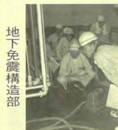
地下免震構造部
