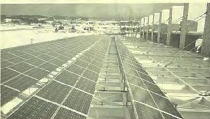
会津大学の北西に位置し、発酵技術科食品技術科、産業工学科を有する。建物本体の上部に太陽光発電システムを採用、外周には半透光型モジュール368枚、中央部には不透光型モジュール1,377枚を設置した。
