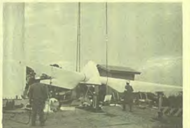
●ブレード吊り込み
