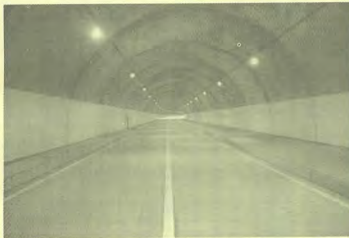
黒森トンネル内部(基本照明)
