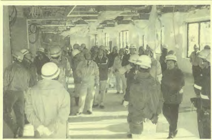
施工者の案内で現場を見てまわる参加者
