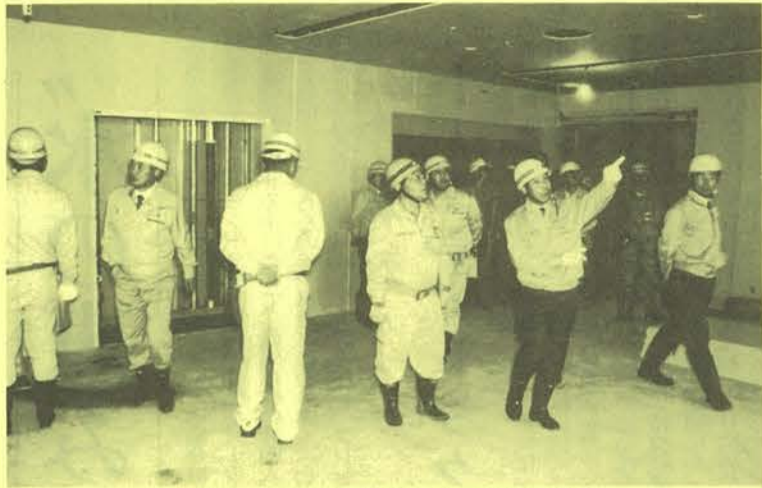
現場内で施工状況を研修する技術委員ら
