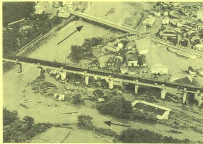
大きな被害となった堀川と阿武隈川の合流点(白河市)
