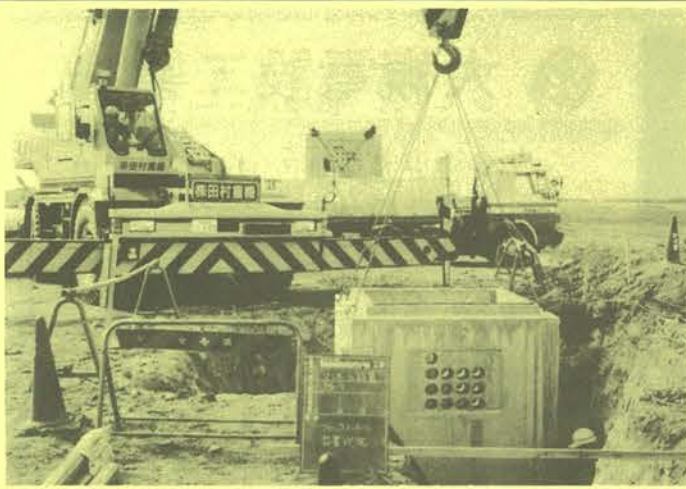
クレーンによるマンホール設置
