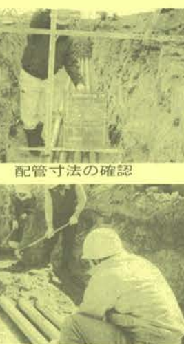
慎重に進められる埋戻し工
