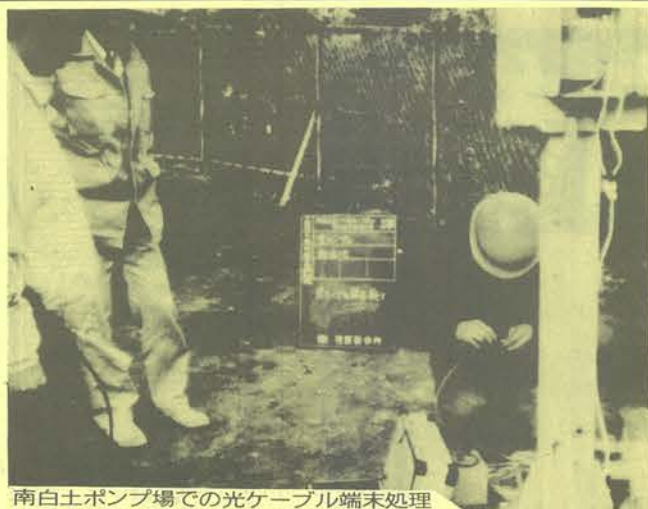
南白土ポンプ場での光ケーブル端末処理
