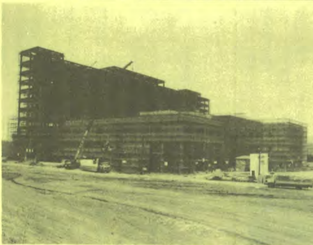
急ピッチで建設が進む医大附属病院
