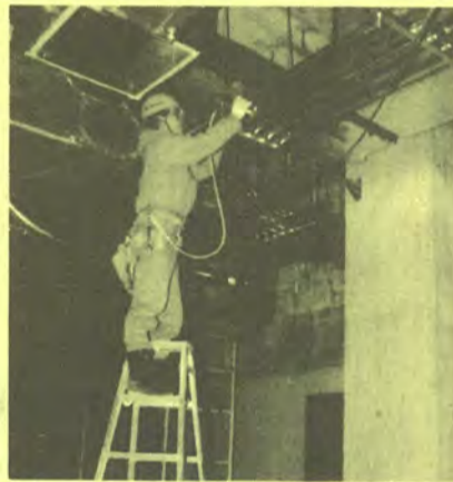
天井内の幹線配管の作業 (工事は仕上げの段階に入る)
