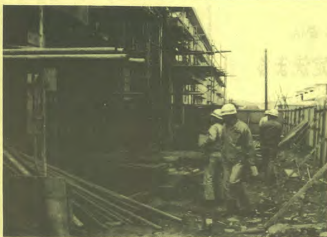
県営住宅鯉岡団地（いわき市）でのパトロール
