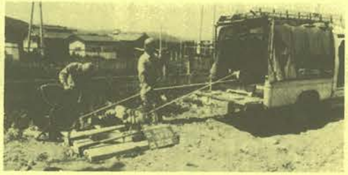
六がある(ソ)と(オ)の間でした。ドラムをハンドホール(ソ)に設置し(オ)に引いたわけですが、ワイ
