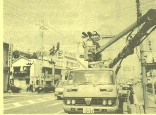
国道4号大町星病院角での作業(郡山支部)
