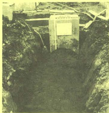
悪土に悩ませられた掘削
