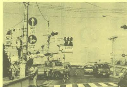
西町二線橋東での作業(福島支部)
