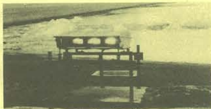
進入角指示灯
