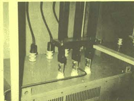
CV-Fケーブルトランス立上げ部分
